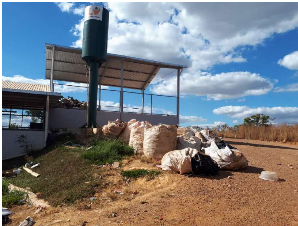
Galpão da Associação Acobraz. Em detalhe à esquerda a área de despejo; e à direita, área de estocagem de bigbags com materiais triados
